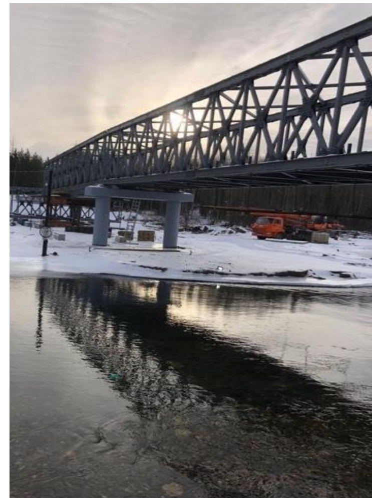
ПЕШЕХОДНЫЙ МОСТ РЕКА ЛОЗЬВА,
