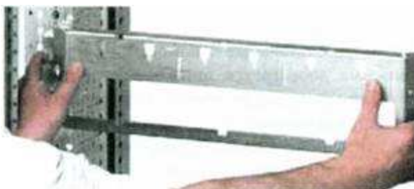
Рисунок 7.12 – Установка монтажной пластины
