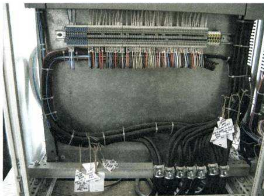
Рисунок 7.33 – Подвод контрольных кабелей снизу электроконструкции
